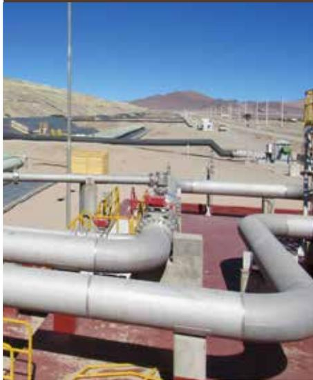
La Gerencia de Procesos, en conjunto con la Gerencia de Ingeniería y Servicios, implementó un sistema de bombeo que permite asegurar la continuidad operacional. Se trata de la Bomba Booster, que proporciona altura para llegar a los pisos superiores de las pilas, obteniendo un regadío permanente de éstas con ILS (solución intermedia).
